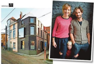
Niets aan de donkere buitengevel doet vermoeden hoe spectaculair het er vinnenbinnen uitziet.
